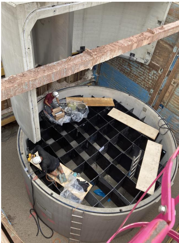
Bild 7 FiltaPex® · modular I pur DN 5600 (ohne Filter), (hier: Herzogenaurach – Gewerbegebiet Nord, Setzen in der Baugrube am 16.09.2021)
