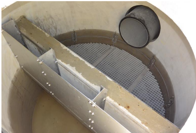
Bild 6 Standardsystem DN 2400 in Betonausführung, FiltaPex® · standard BE-2400 (hier: Diebesweg in Möchengladbach, Inbetriebnahme am 30.06.2015)
