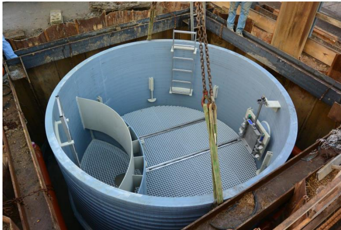
Bild 7 Standardsystem DN 3400 in Kunststoffausführung, FiltaPex® · standard WE-3400 (hier: Gink in Erkrath, Inbetriebnahme am 21.10.2014)
